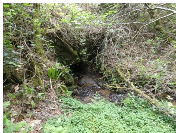
⑥ Ouvrage de franchissement du Kerly
