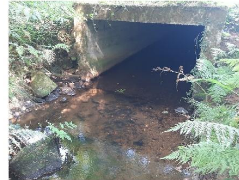
Ouvrage de franchissement de la RD 769 (amont)
