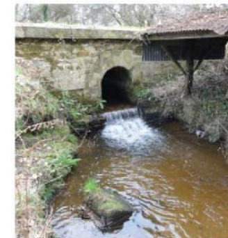
Ouvrage de franchissement de la RD 782 (chute aval ± 50 cm et plat courant amont)
