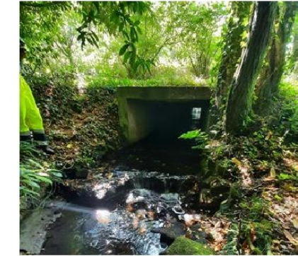
Ouvrage de franchissement de la RD 769 (aval)
