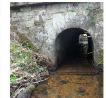
Ouvrage de franchissement de la RD 782 (chute aval ± 50 cm et plat courant amont)
