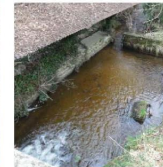
Ouvrage de franchissement de la RD 782 (chute aval ± 50 cm et plat courant amont)
