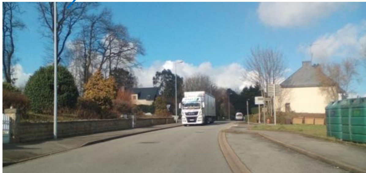
Photo 221 : RD790 – carrefour de l'accès au centre aquatique
