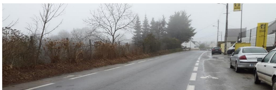
Photo 213 : La RD790 au nord du centre-ville de Le Faouët
