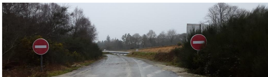
Photo 212 : L'ancienne bretelle de sortie de la RD769 vers le centre-ville de Le Faouët
