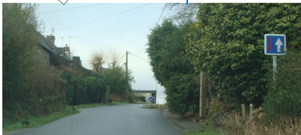
Photo 222 : Voie communale n°11 – traversée du hameau de Coat Loret
