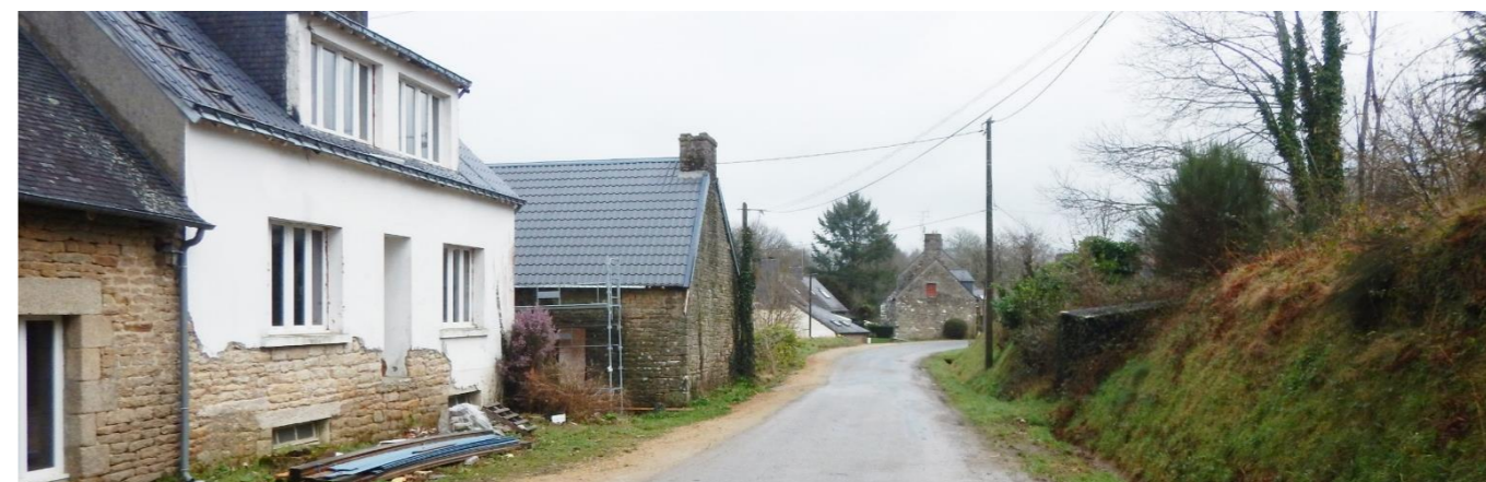
Photo 106 : Le hameau de Coat-en-Haie à l'implantation bâtie linéaire
