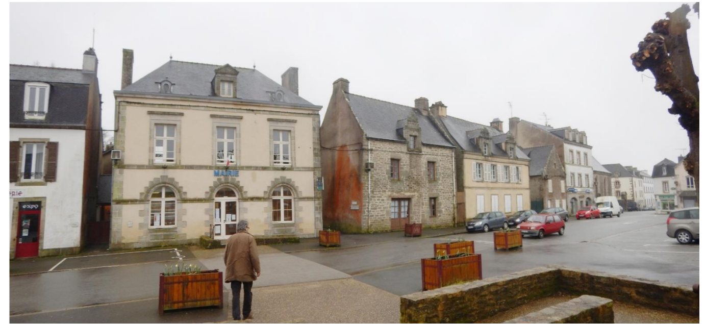
Photo 136 : Les lucarnes protégées d'une maison – deuxième à droite de la mairie
