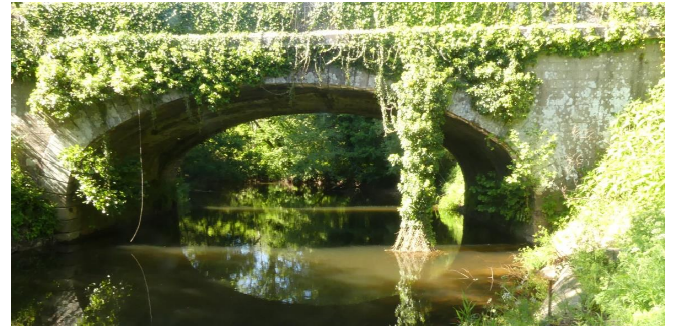
Photo 6 : Pont sur l'Inam sur la RD782 – Extrémité ouest du fuseau d'étude
