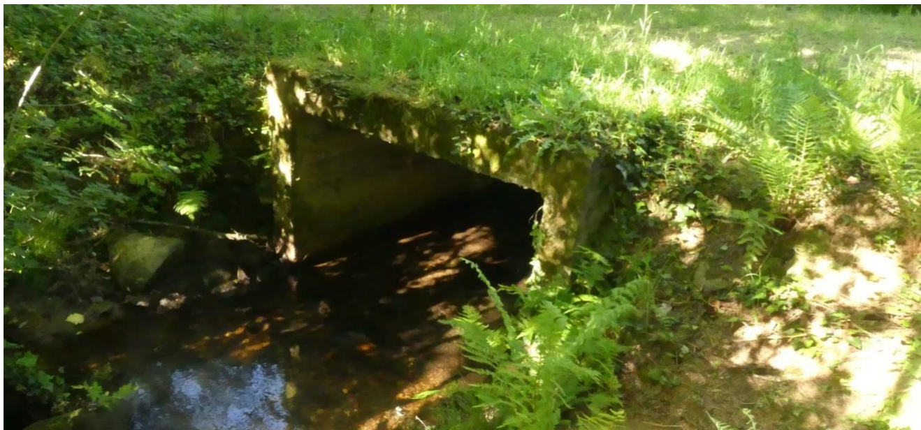
Photo 3 : OH-PC-1 (2,00 x 1,10) sous la RD 769
