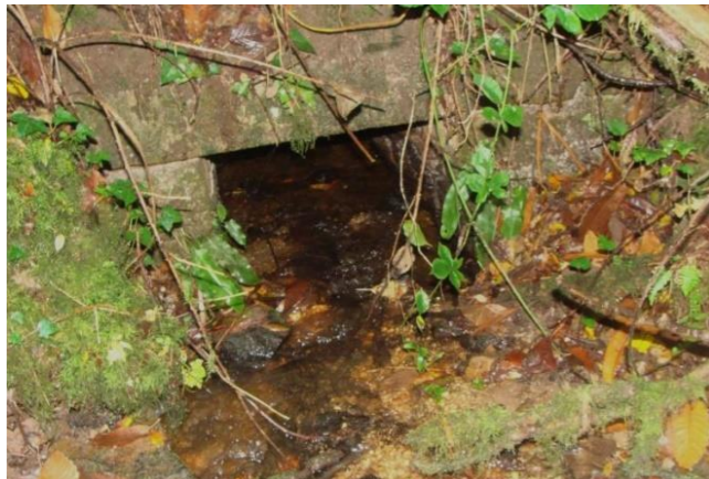
Photo 7 : OH-K-1 (0,70 x 0,55) sous la voie communale
