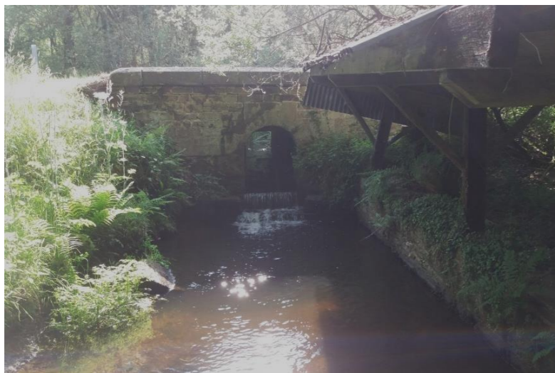
Photo 4 : OH-PC-2 (1,00 x 1,20) sous la RD 782
